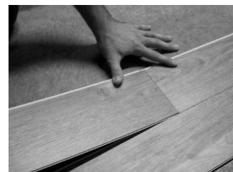
Fig. 5 – Orientez l'extrémité de la planche suivante.
