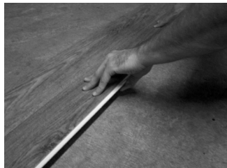
Figura 4. Incline el lado largo en la hilera anterior.
